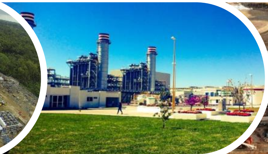
Centro Morelos 724 MW
