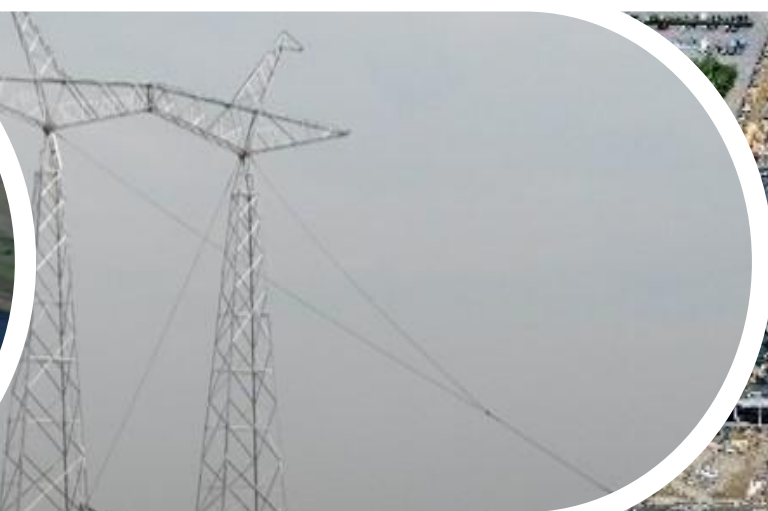
Líneas de transmisión
