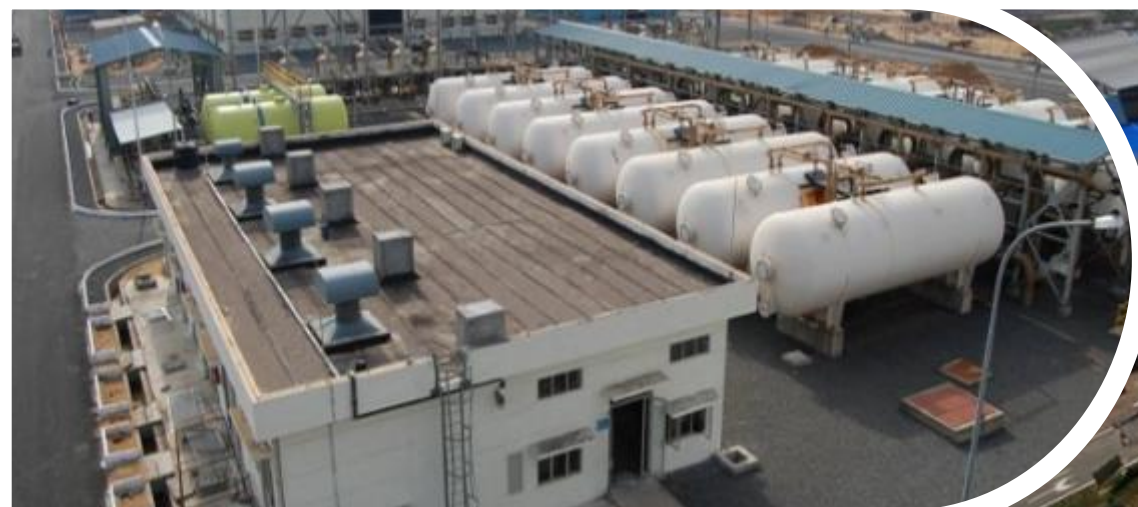
Planta desaladora de Chennai
