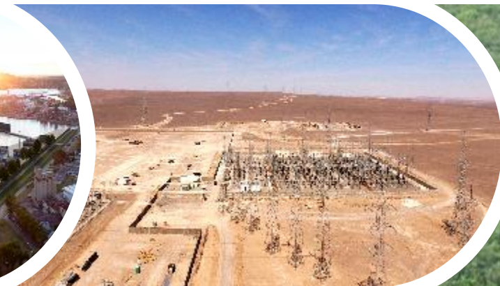
Línea Changos - Kimal 500 kV
