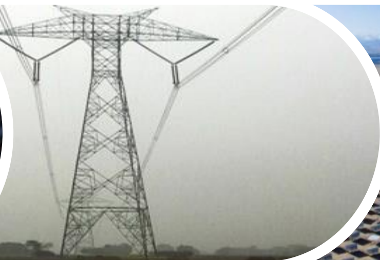
Líneas de transmisión
