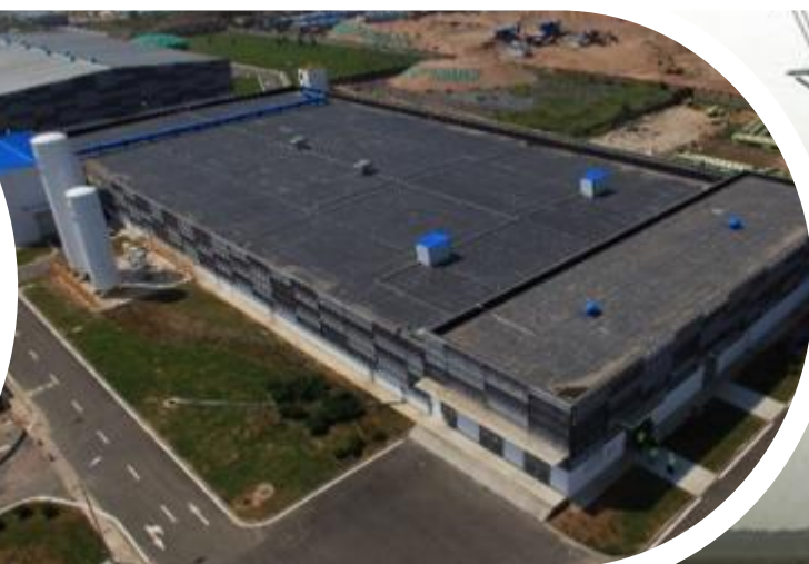
Planta desaladora de Qingdao
