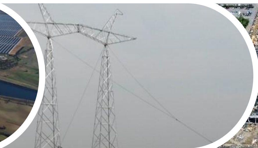
Líneas de transmisión
