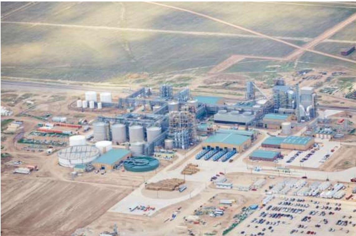
Situada en Hugoton, Kansas (EE. UU.), la nueva planta de producción de etanol a escala comercial de Abengoa utilizará alrededor de 300.000 toneladas secas de residuos agrícolas para la producción de más de 25 Mgal de etanol lignocelulósico y 21 Mw de electricidad renovable.
