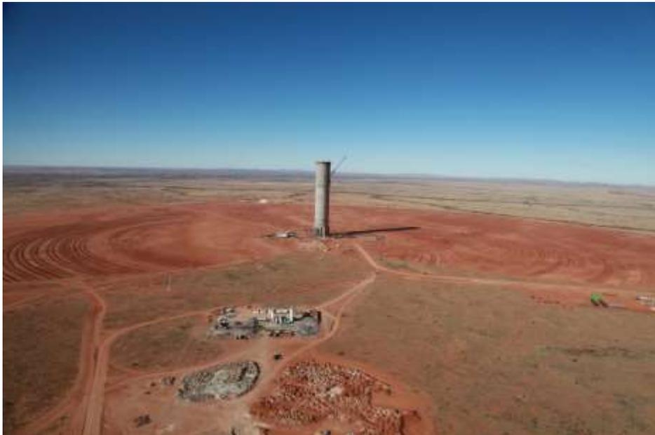
Khi Solar One, una planta de torre de 50 MW y dos horas de almacenamiento de vapor, utiliza vapor sobrecalentado y un sistema de refrigeración seca para reducir el consumo de agua. KaXu Solar One, una planta de colectores cilindroparábólicos
