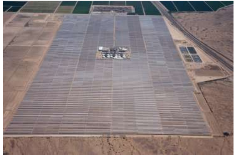
Vista aérea del campo solar. (Foto tomada en julio 2013)
