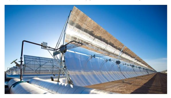
La tecnología cilindroparabólica es una solución madura y viable, con más de 25 años de experiencia. Este sistema se probó con el lanzamiento de las primeras plantas de colectores cilindroparabólicos en los EE.UU. (Solar Energy Generating Systems en California).
