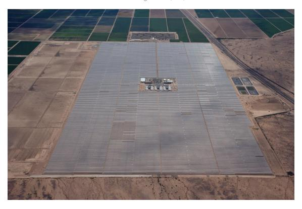
Solana, la planta cilindroparabólica más grande del mundo con una capacidad instalada de 280 MW (brutos) y un sistema de almacenamiento de energía térmica de seis horas, permite satisfacer los picos de demanda de la región por la noche, especialmente en verano. Su campo solar se extiende por 777 ha, con aproximadamente 3.200 colectores de espejos cilindroparabólicos.
