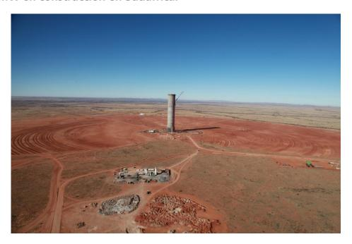
Khi Solar One, una planta de torre de 50 MW y dos horas de almacenamiento de vapor, que utiliza vapor sobrecalentado y un sistema de refrigeración seca para reducir el consumo de agua. KaXu Solar One, una planta cilindroparabólica de 100 MW con tres horas de almacenamiento en sales fundidas.
