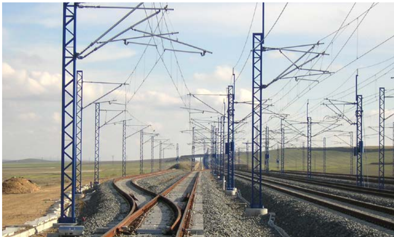
► El proyecto de innovación Alis confiere seguridad y eficiencia a los sistemas ferroviarios.
