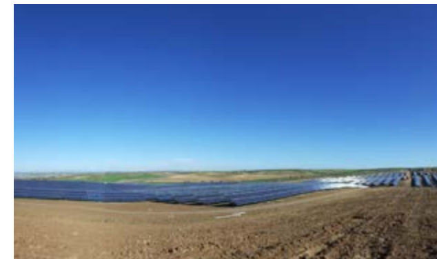
► Abengoa desarrolla la ingeniería constructiva de una planta fotovoltaica en Barciencia (Toledo).
