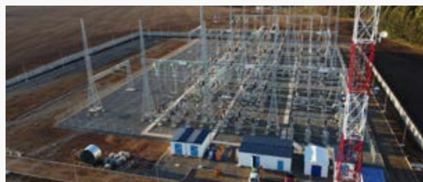
► Durante el pasado año, Abengoa concluyó la construcción de la subestación Malleco de 220 kV.
