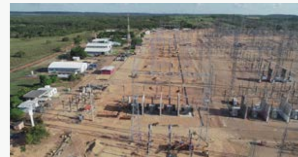
► La compañía se ha adjudicado la obra civil y montaje de la subestación de 500 kV Miracema.
