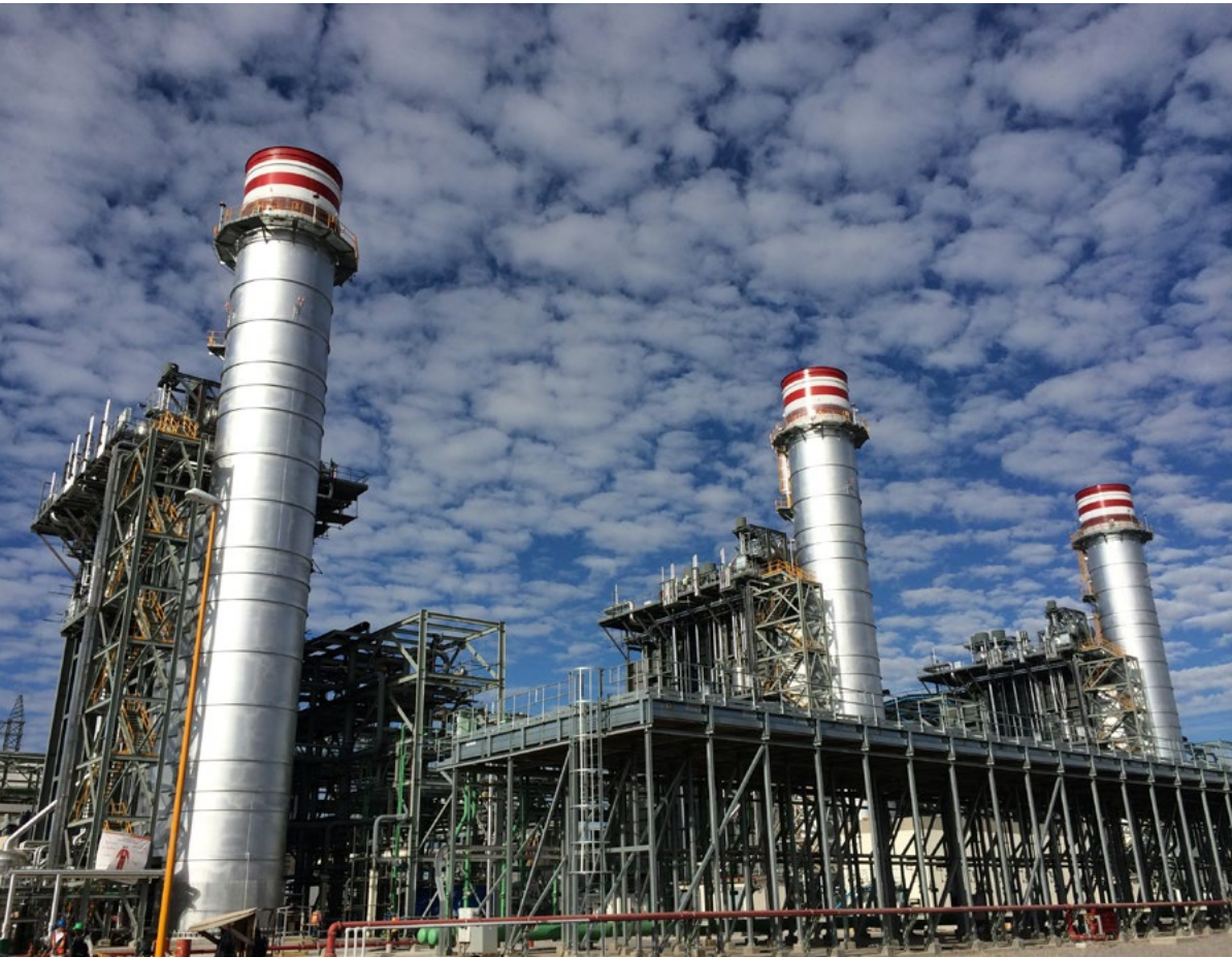
Abengoa está construyendo la mayor planta de ciclo combinado de México
