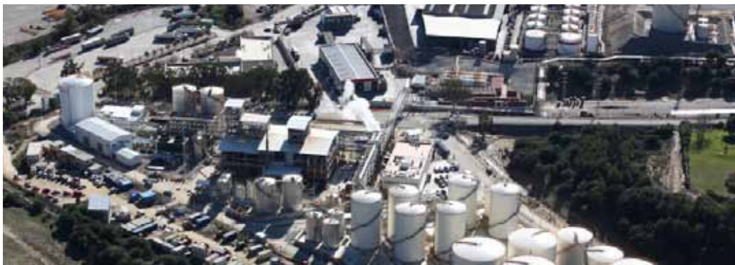
Planta de biodiésel en San Roque, Cádiz
