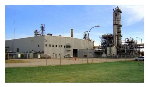
El  $\mathrm{CO_2}$  producido es capturado y refinado por un cliente in situ. El DGS producido no se seca en el proceso; se vende el 100% del coproducto en su estado natural. Se puede usar maíz y sorgo simultáneamente, aunque la materia prima principal es el sorgo, y más del 50 % de la energía requerida por la planta es proporcionada por el metano de un vertedero de desecho sólido municipal. Actualmente tiene 48 profesionales altamente cualificados.
