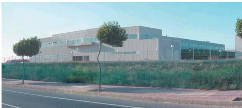
Planta desaladora del Bajo Almanzora (Almería). El contrato incluye su construcción, operación y mantenimiento por 15 años. El proceso de desalación de la planta será el de ósmosis inversa y dispondrá de la tecnología más eficaz en recuperación de energía disponible en la actualidad: cámaras isobáricas. La capacidad de la planta, 60 000 m<sup>3</sup> de agua al día, beneficiará a 15 municipios y a un área de más de 12 031 hectáreas de producción agraria.
