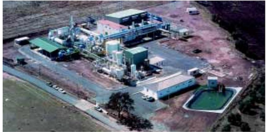
Ampliación de la EDAR de Barranco Seco II (Las Palmas), para una población de 245.000 habitantes, mediante tratamiento terciario con electrodiálisis reversible (EDR) para la utilización en regadío de 26.000 m<sup>3</sup>/día, para el Ministerio de Medio Ambiente.
