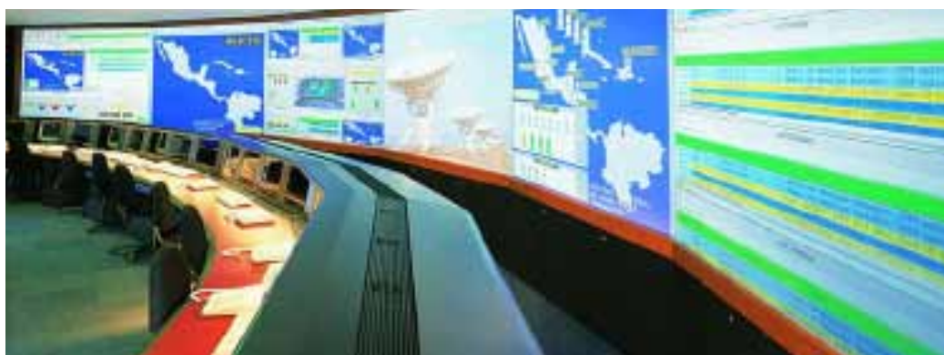
Pemex control center
