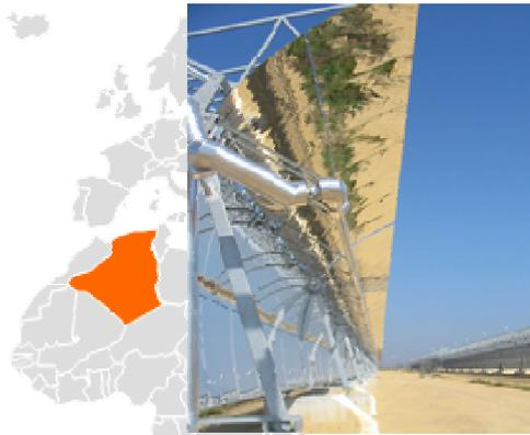
Espejos cilindro-parabólicos en Hassi-R'mel
