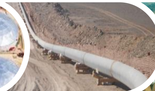
Tierra Amarilla Aqueduct Chile
