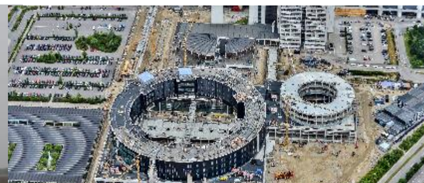
Instalaciones electromecánicas Dinamarca
