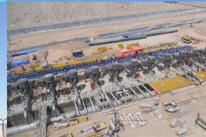
Montaje electromecánico Minera Escondida BHP
