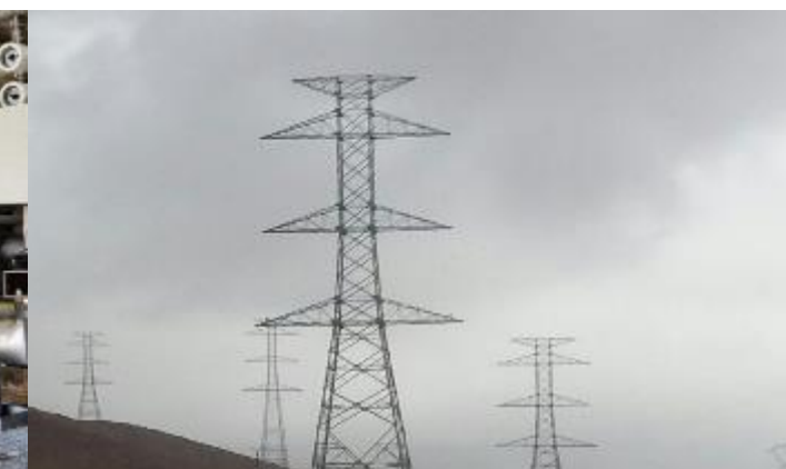
Línea 225 kV Marruecos
