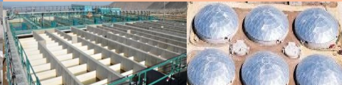
Sistema Abastecimiento y Saneamiento Cunene Angola
