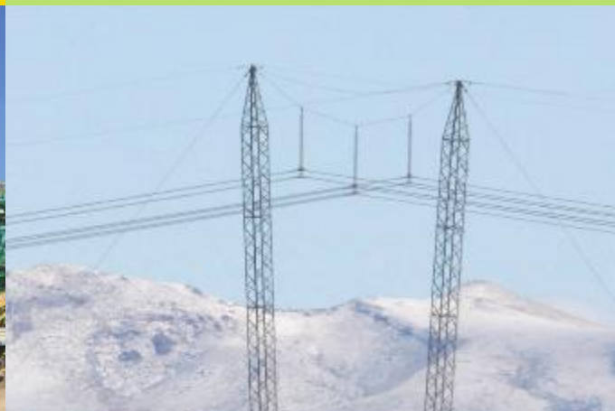
Neuquén - Mendoza Línea 500 kV
