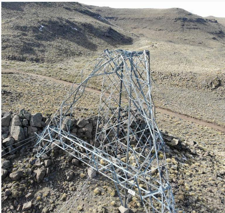
Obra Reparación Línea 330kV Futaleufú: Estado Antes.
