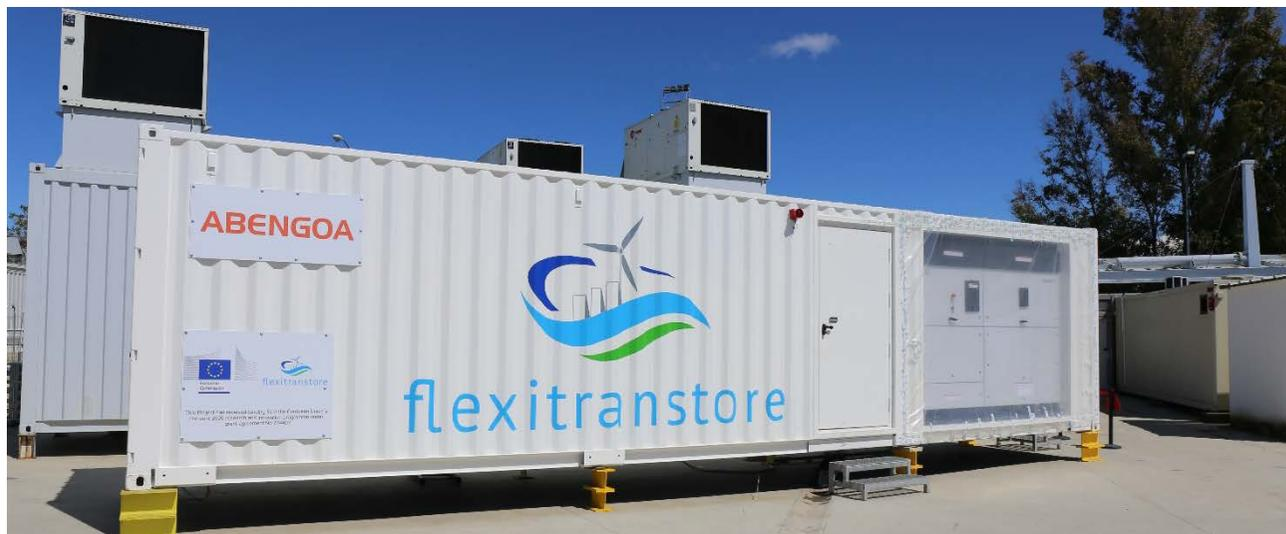
□ Contenedor BESS instalado en la subestación de Athienou (Chipre).
