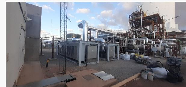
□ Booster heater de Khi Solar One, elemento no contemplado en el diseño original de la central y que se incluyó en el Plan de Acción.
