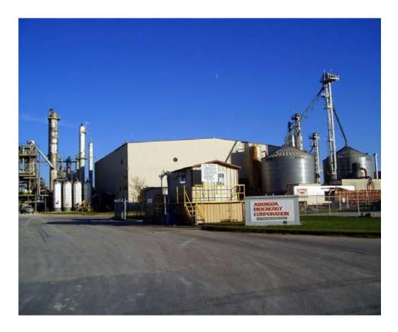
En 2006 se realizaron trabajos de expansión duplicando la producción empleando procesos de cocción y fermentación por lotes, con dos fases separadas de destilación y deshidratación. El DGS producido no se seca en el proceso, se vende el 100 % del coproducto en su estado natural. Se pueden emplear simultáneamente maíz y sorgo. La capacidad de producción es de 125 ML anuales de bioetanol. La planta cuenta en la actualidad con 48 profesionales altamente cualificado.
