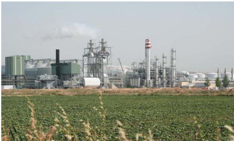
hidrólisis enzimática con celulosas y la posterior fermentación de los azúcares liberados con levaduras disponibles comercialmente. La planta tiene una capacidad de 5 millones de litros al año de bioetanol
